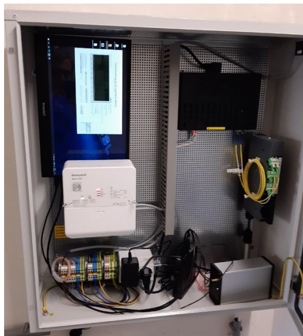
Abbildung 3.28: Einbau des Messsystems PLC-SM-LZM (FCC), siehe Anhang, am Gateway in einer Trafostation.
