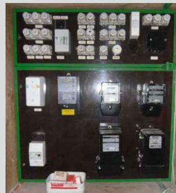
**Seitenwände aus Holz** sind aus Brandschutzgründen nicht mehr zulässig. Dringend von einem Elektriker überprüfen und erneuern lassen.
