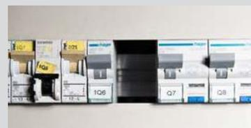
**Fehlen Abdeckungen**, ist man vor spannungsführenden Teilen nicht mehr geschützt. Unbedingt von einem Elektriker ersetzen lassen.
