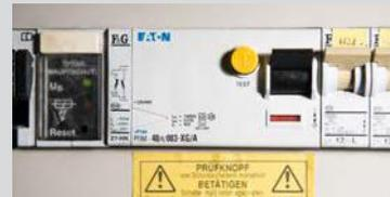
**Den Testknopf** (Bildmitte) regelmäßig drücken. Löst der FI-Schutzschalter daneben nicht mehr aus, unverzüglich einen Elektriker kontaktieren. Dasselbe gilt, wenn die Sicherungsautomaten (rechts) häufig auslösen.
