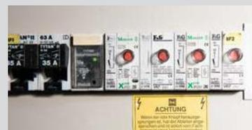
**Der Überspannungsableiter** findet sich meistens unten im Verteiler. Nach jedem Gewitter überprüfen. Leuchtet er rot, können elektronische Geräte Schaden nehmen.
